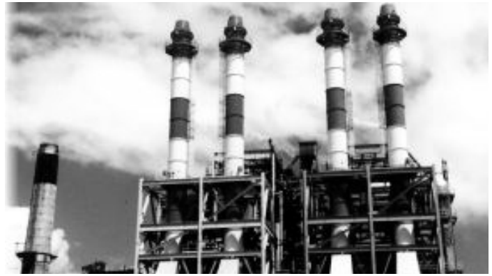
Planta contaminante de la AEE en Palo Seco
